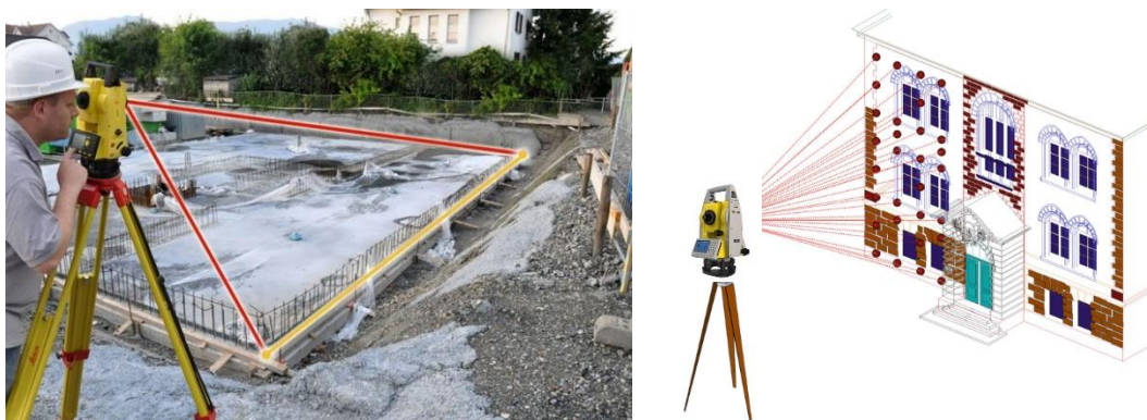
Figura 4. Rilevamento con tachimetro e rilievo As-built
